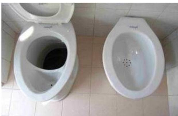
Figure 3: Inodoro seco estándar con separación de orina (foto: GIZ Filipinas)
