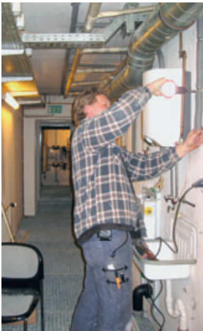
Montage der Zuleitungen. Verwendet werden nur noch Rohre mit Nennweite 12 mm
