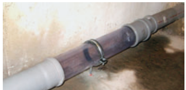
Trotz 80er Rohre kein Problem mit dem Ausschwemmen. Transparente Teilstücke erlauben eine permanente Kontrolle
