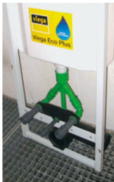
Verlängerung für das „Geweih“. An manchen Stellen muss noch improvisiert werden
