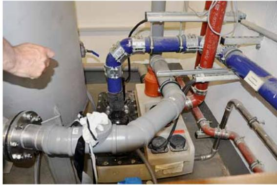
Die räumliche Enge verlangte einige Rohr-Lyrik zum Anschluss der Braunwasseranlage. Ganz rechts (blau) die Druckleitung der Fäkalienhebeanlage
