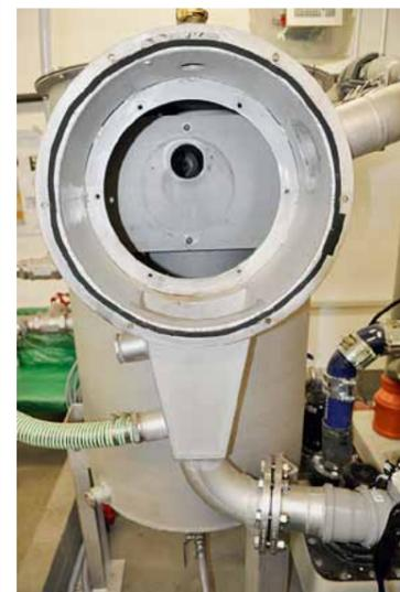
Vorreinigung Braunwasser zur Trennung von Fäkalien und Toilettenpapier von der flüssigen Phase. Allerdings ist die Siebschnecke, die die Phasen trennt, im Bild demontiert. Bei dem Saniresch-Projekt werden die Nährstoffe in den Fäkalien und Toilettenpapier nicht genutzt. Die Feststoffe gelangen über den Trichter (vorne) zur Fäkalienhebeanlage, die Flüssigkeit fließt zur Grau-/Braunwasser-Aufbereitung
