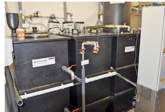
Speichertanks, in die das gereinigte Grauwasser/Braunwasser über die Membranen des Membranbioreaktors gezogen wird. Das so entstandene Servicewasser nutzt die Gebäudetechnik der GIZ an verschiedenen Stellen
