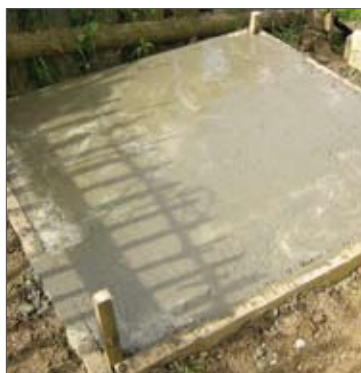
Фиг.3: Бетонен под за фекалните камери - кофраж (горе), завършен под (долу)
