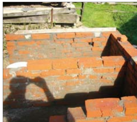
Фиг.4: Строеж на външните тухлени стени на фекалните камери (ляво), отвор за тръбата с урината (дясно)
