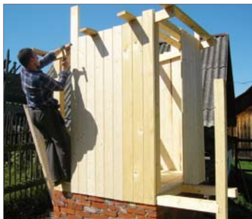
Фиг. 6: Направа на рамката за дървените стени на тоалетната настрани (горе), наковане на стените с дъски - 2 см (долу).
