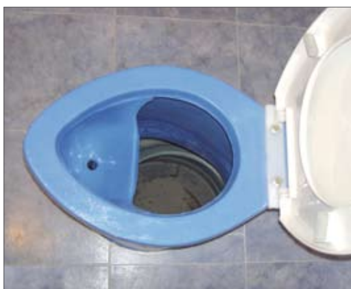
Фиг.8: Разделна тоалетна чиния в читалището на с.Сулица (ляво) и разделна тоалетна - тип клекало (дясно)
