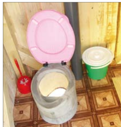
Фиг. 1: Суха разделна тоалетна с две камери: изглед отвън (ляво) и изглед отвътре (дясно).
