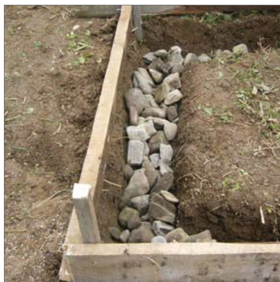
Фиг. 2: Изкопаване на основи (горе) и насипване с камъни (долу)
