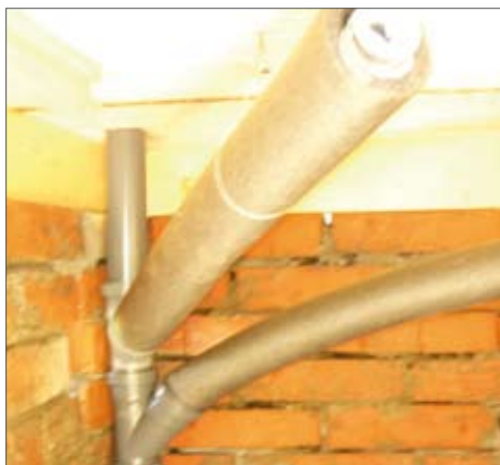
Фиг.10: Фекална камера отвътре с топлоизолиран маркуч за урината - 25 мм, и полипропиленова тръба - 50 мм (ляво). Малък 20 литров контейнер за урина извън тоалетната (дясно)
