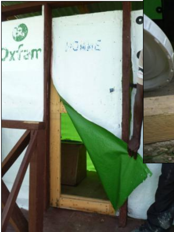
MOVE FOTO T7: Timoun yo rache fèy plastik la espre pou yo sa antre nan twalèt la.
