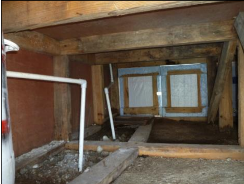
MOVE FOTO T5: Premye plonbri yo, ak koub 90 degre a ki te kont fè tiyo a bouche.
