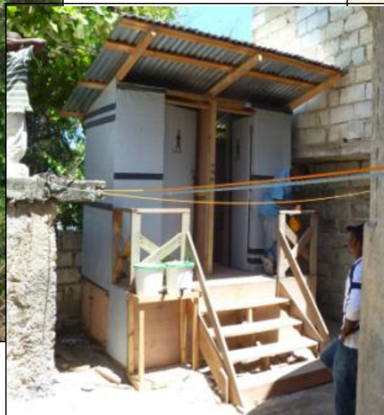
FOTO T16b: Yon BON pozisyonman twalèt UD SOIL, avèk jis ase plas pou ou rive nan chanm yo.
