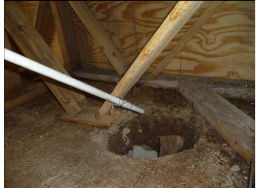
MOVE FOTO T6: Yon tiyo ki mal enstale, li pa antre nan pwi pèdi a.
