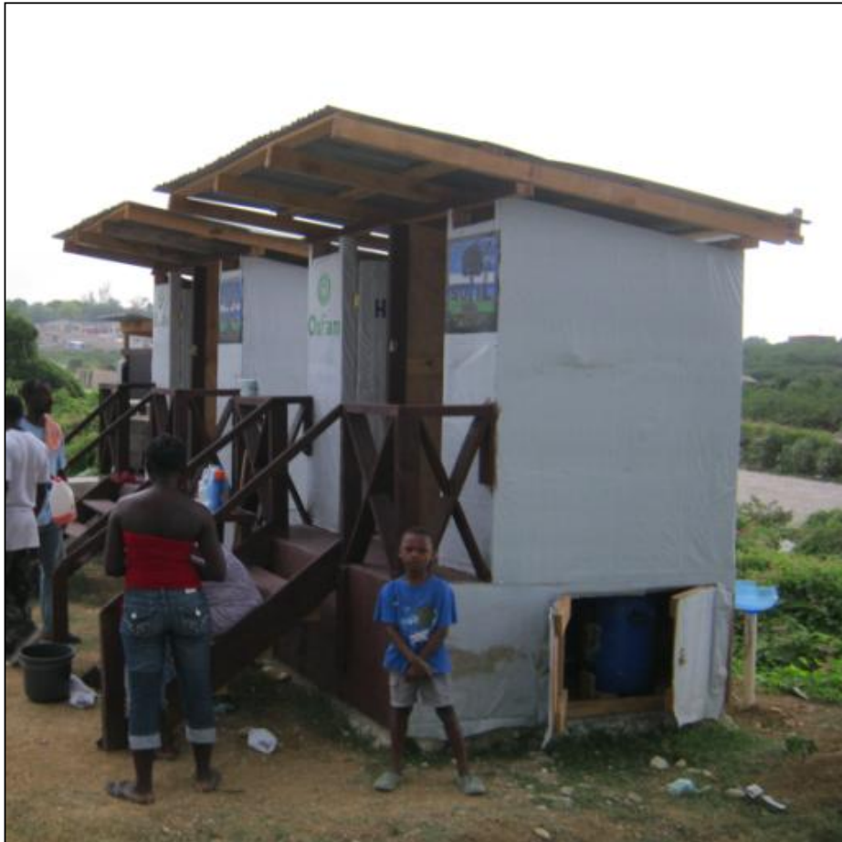
FOTO T11: Vi sou kote, ki montre pòt chanm yo.
