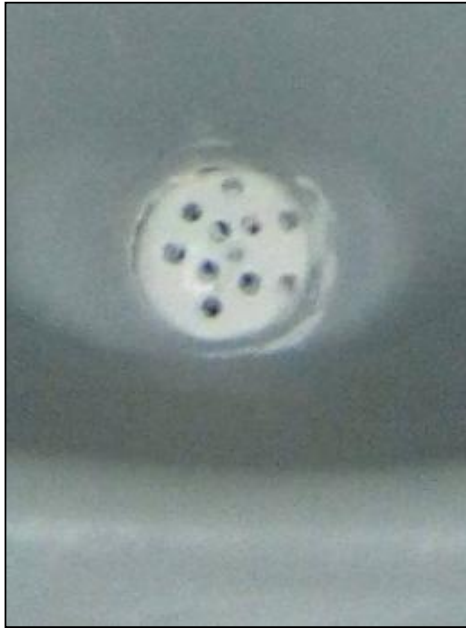
MOVE FOTO T4a: Premye tèt twalèt UD SOIL ak twou pou drenaj pipi a, SAN filt.
