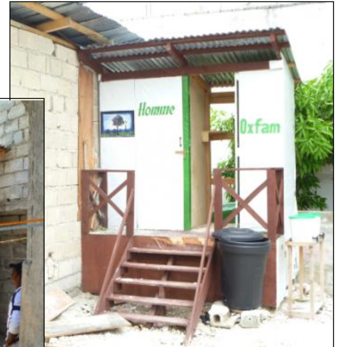
FOTO T16c: Yon MOVE pozisyonman twalèt UD SOIL, pa gen ase espas pou rive nan chanm yo.
