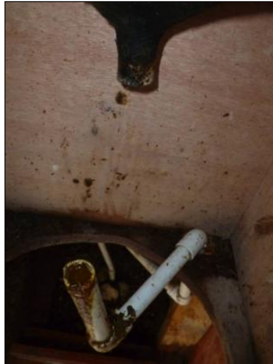
MOVE FOTO T2: Yon tiyo pipi yo detache de tèt twalèt la paske li bouche, nan yon twalèt UD SOIL.
