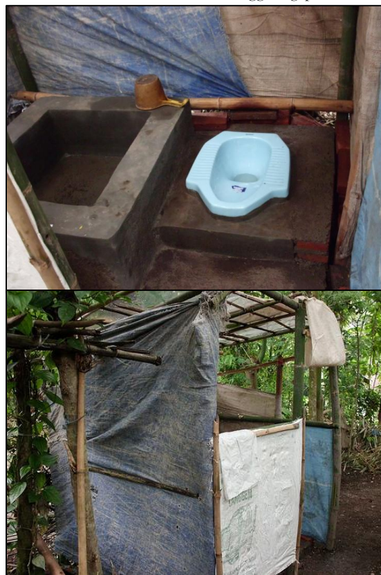
Pour flush latrines with tarp walls
