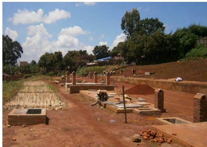
Abbildung 33: Mehrkammergrube und bewachsener Bodenfilter der Kleinkläranlage in Shatanya, Quelle: Fichtner
