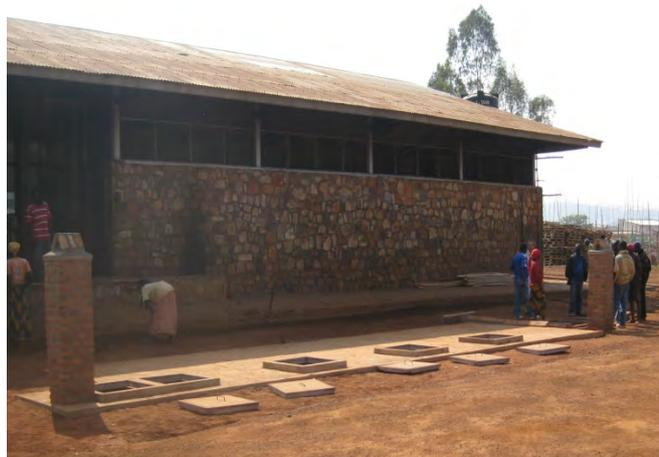
Abbildung 26: Mehrkammergrube, der Kleinkläranlage des Schlachthofs, eigene Quelle
