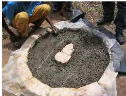
Abbildung: 48, 49: Konstruktion einer Sanplat, Quelle: Fichtner
