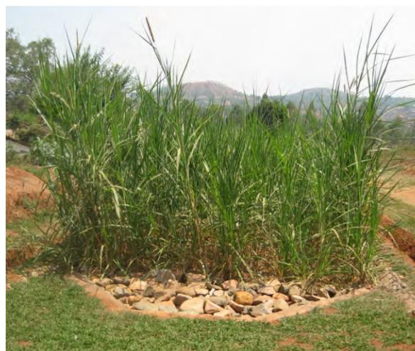
Abbildungen 27, 28: Bewachsener Bodenfilter des Schlachthofs, Abdichtung aus Ton und Kiesschicht, Elefantengras, Quelle: Fichtner
