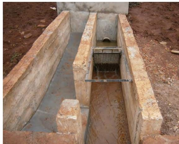
Abbildung 32: Rechen mit Bypass der Kleinkläranlage von Shatanya, Quelle Fichtner
