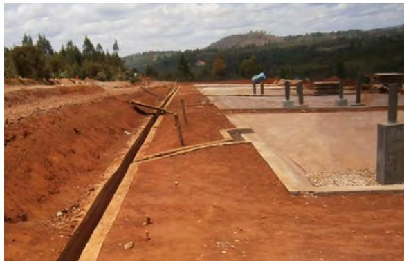
Abbildung 38: Transportkanal zu den Filterbecken, Quelle Fichtner
