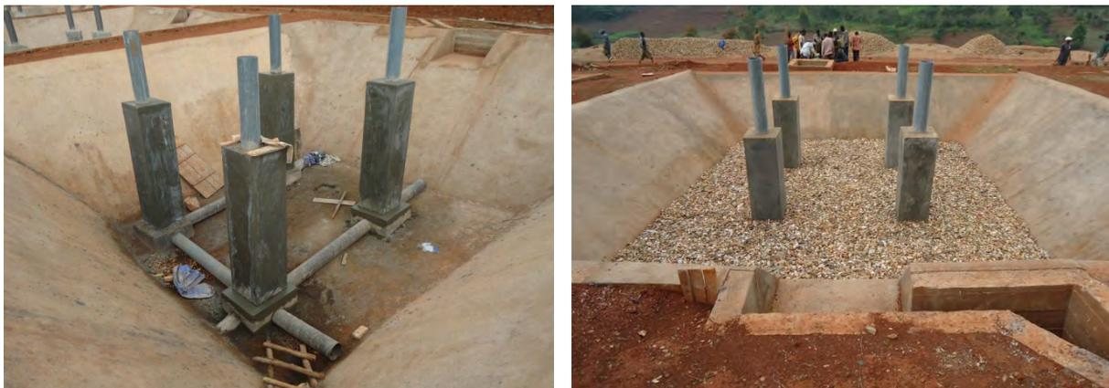
Abbildung 39, 40: Filterbecken mit Drainage und Belüftungsrohren (links), mit Kiesschicht (rechts)
