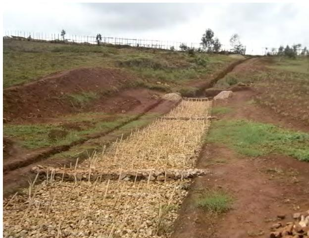
Abbildung 43: Bewachsener Bodenfilter der Schlammbehandlungsanlage (Aufnahme von unten), Quelle: Fichtner
