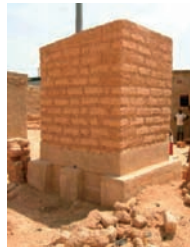
Double fosse totalement en matériaux locaux 129 000 FCFA
