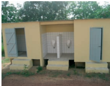
Latrines + urinoirs, Usine Toupah-SAPH
