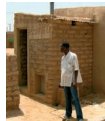
Box - avec superstructure en banco 102 000 FCFA
