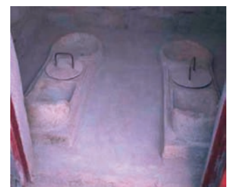
Latrine ECOSAN avec UNICEF
