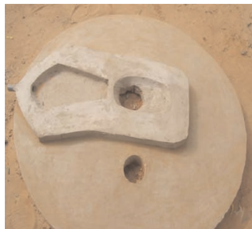
Dalle SanPlat sans fer avec séparation d'urine proposée par Djariri (2009).
