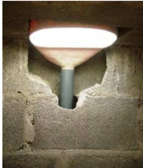
FOTO N° 12: Vista interior con taza
