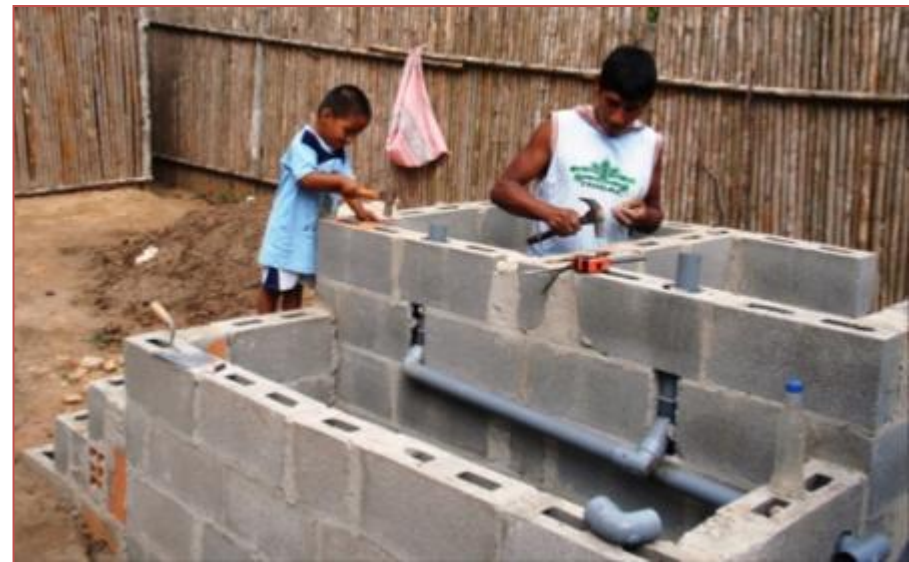
FOTO N° 13: obra con tubo de orina instalado
