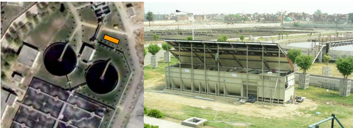
Bild 6: System S&P Scheibentauchkörper auf der Yamuna Vihar Kläranlage, Neu Delhi
