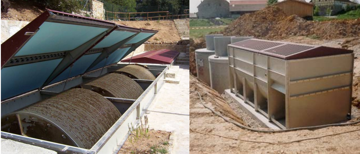
Bild 2: Erdeingebaute System S&P Scheibentauchkörper (rechts in Spanien / links in Deutschland)
