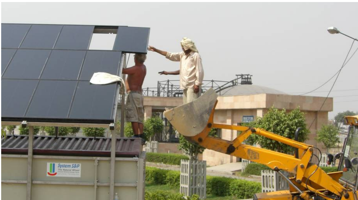
Bild 4: Solarzellenmontage über dem System S&P Scheibentauchkörper
