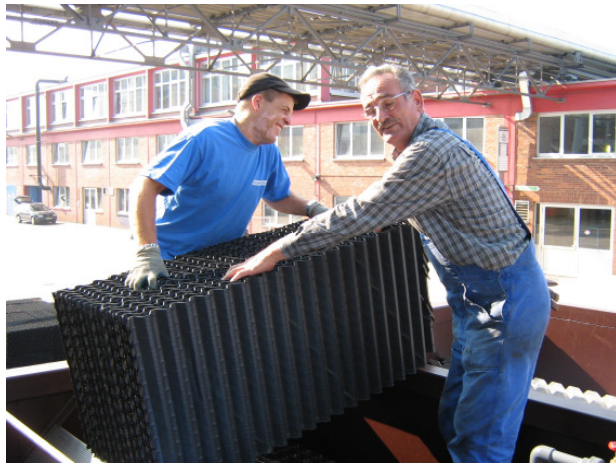
Bild 5. Einbau der Festbett-Füllkörper durch Beschäftigte der 2H-Kunststoff in die C-stufe mit vertikalen Festbettkanälen.
