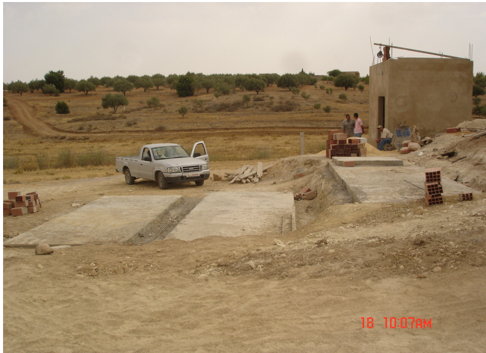
Bild1 : Infrastrukturvorbereitung für den Betrieb der Anlage; Vorne: die Fundamente; hinten: Betriebsgebäude
