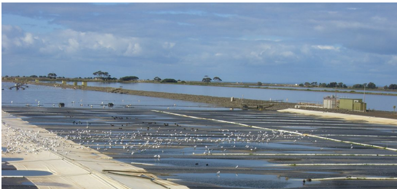
Bild 3.1: Western Treatment Plant bei Werribee, Australien; im Vordergrund abgedeckte Teichfläche zur Biogasgewinnung (Foto: Rudolph)
