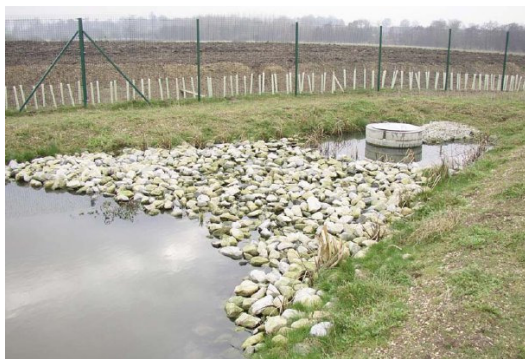
Bild 3.14: Filterdamm (Rock Filter) vor dem Ablauf eines Fakultativteichs in Großbritannien (Mara, 2006a)
