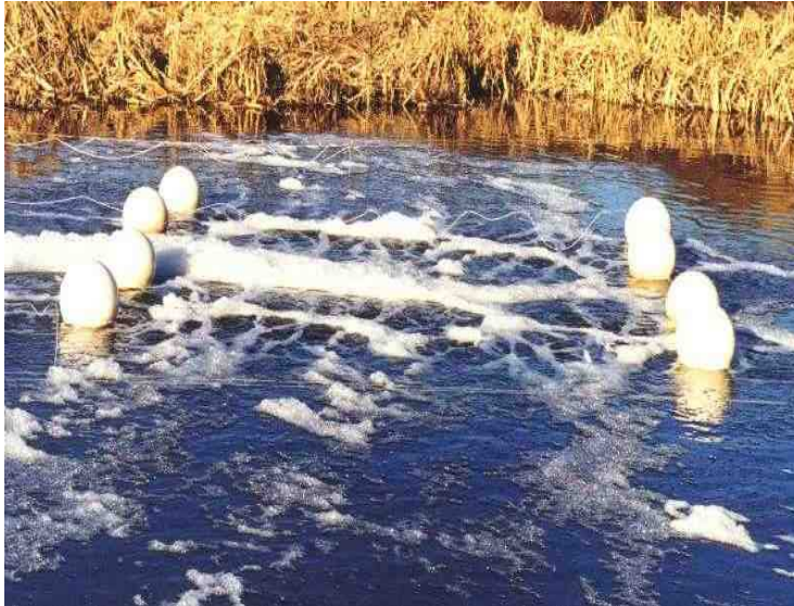
Abbildung 3: Belüfteter Abwasserteich für 78 Einwohner in Groß Flotow (TU Berlin).
