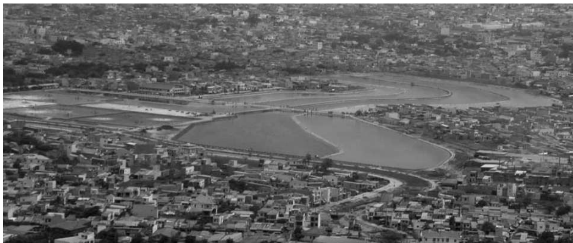
Bild 2.11: Abwasserteichanlage Bin Hung Hoa in Ho Chi Minh City, Vietnam (30.000 m 3 /d)
