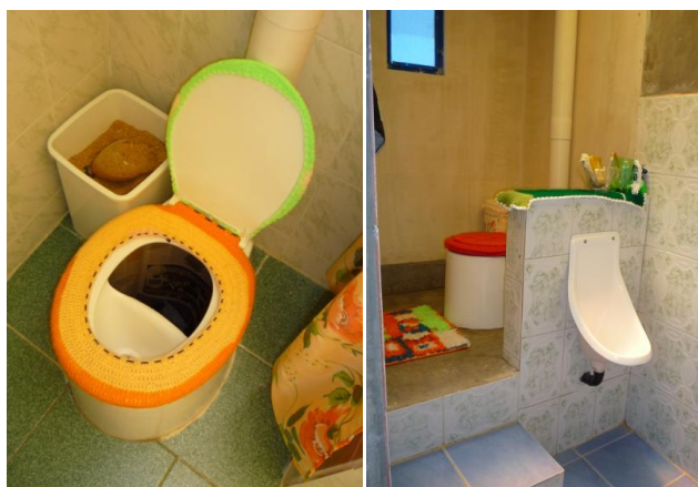
Fig. 9: Vista interior del baño seco con desviación de orina. A la derecha el orinal (Andersson, 2011).
