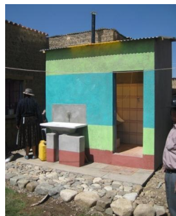
Fig. 8: Vista frontal del baño seco con desviación de orina con lavamanos en la parte exterior (Andersson, 2011)
