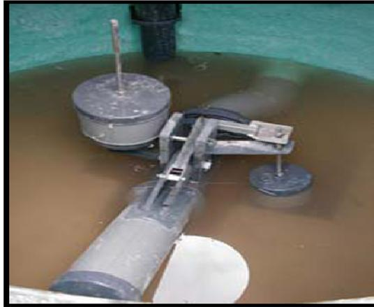
**Figure I.11:** *L'alimentation par bâches et par chasses pendulaires*
