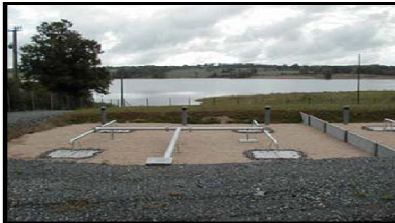
***Figure I.13: Répartition des effluents par une rampe***
