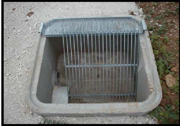
**Figure I.2:** le dégrilleur manuel
