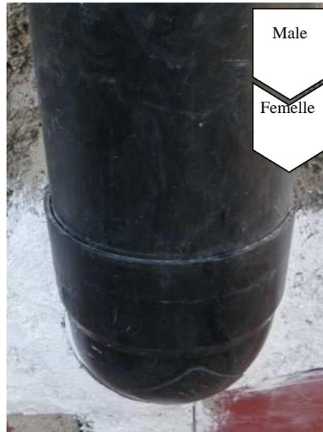
**Photo2 : Mauvais raccordement : femelle dirigé vers la haute possibilité d'infiltration d'eau.**
