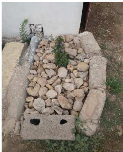
**Figure 31: puits d'infiltration des eaux de nettoyage anal**
