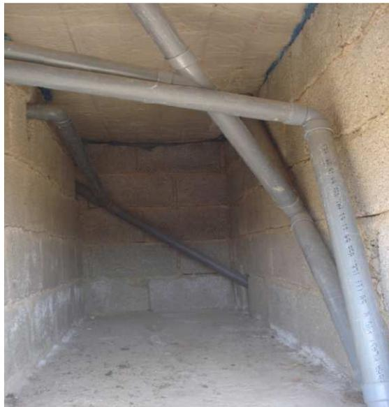
**Figure 26: utilisation de canalisations pour la collecte des flux**
