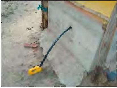
Se debe tener mayor cuidado en la implementación del pipiducto, conectado en la losa superior, y al urinario, el sistema de completarse con el acomodo de recipientes cerrados donde ingresarán los orines.
