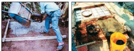
Se procede al vaciado del encofrado con una mezcla al hormigón armado de 1:2:3, rellenando y removiendo hasta lograr un compactado ideal.
