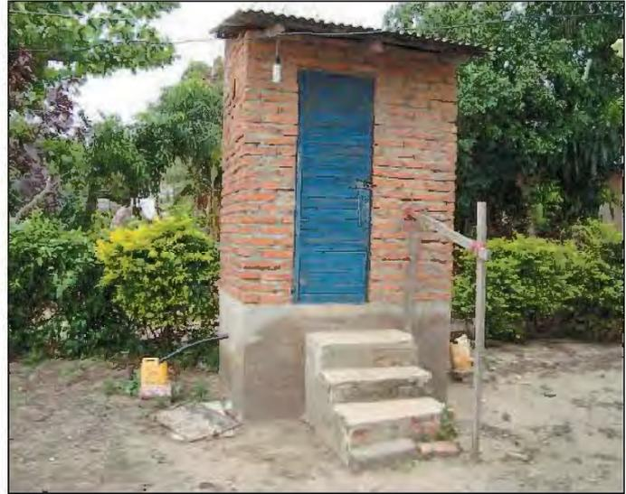
En cuanto los muros y cubiertas, estas fueron construidas por los beneficiarios, según sus recursos como contraparte al proyecto de construcción de baños ecológicos, es así que se puede apreciar muros de chuchió, adobe, latones y calaminas, maderas y en el mejor de los casos con ladrillo, en cuanto a la cubierta se puede apreciar jatata, palma, teja, calamina u otro material que cubra esta función.
