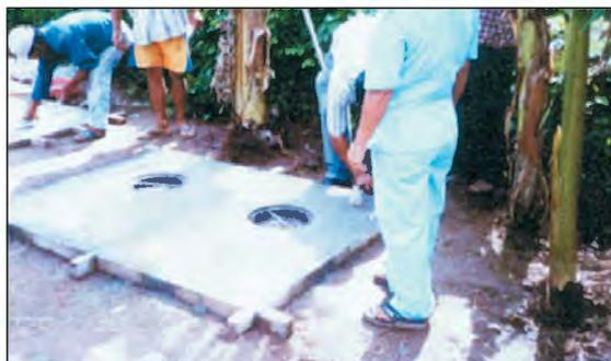
Una vez construidas las lozas inferiores y superiores, se procede a la construcción de los muros correspondientes a las dos cámaras (se construyen con ladrillo adobito, en soguillo), las cámaras se dividen por un muro interno construido con ladrillo en pandereta, trabando en el muro anterior de la cámara.
