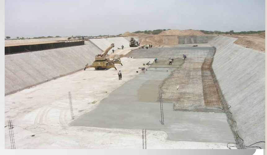
Décanteur en phase de construction
