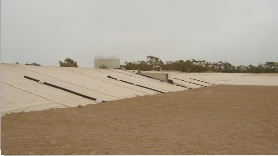
Couche supérieure du graviter de la station d'épuration M'Zar
