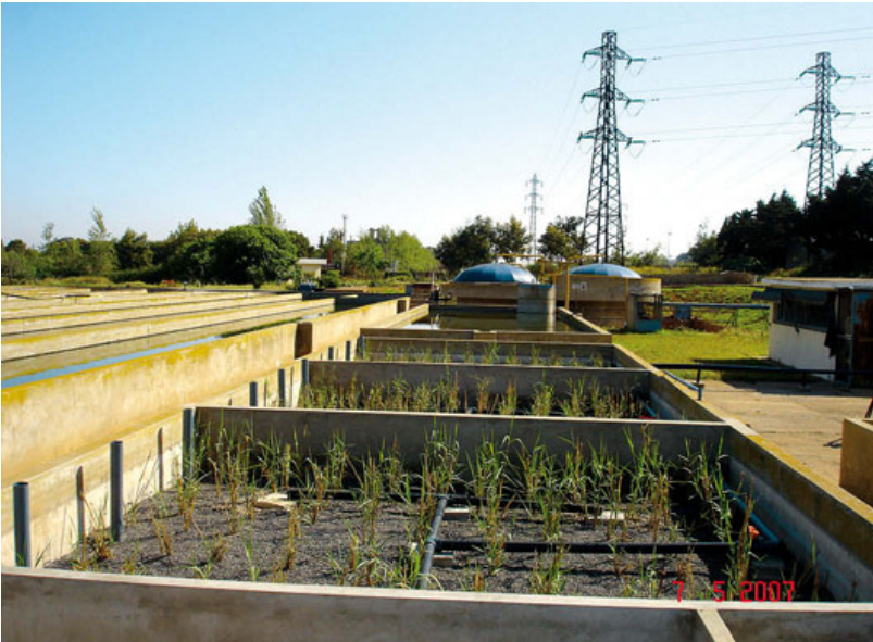
Figure 3: FILTRE PLANTÉ PRÉTRAITEMENT, ÉCOULEMENT VERTICAL
