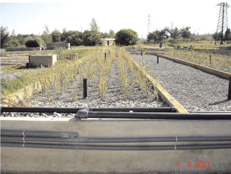
Figure 4: FILTRE PLANTÉ ÉCOULEMENT HORIZONTAL
