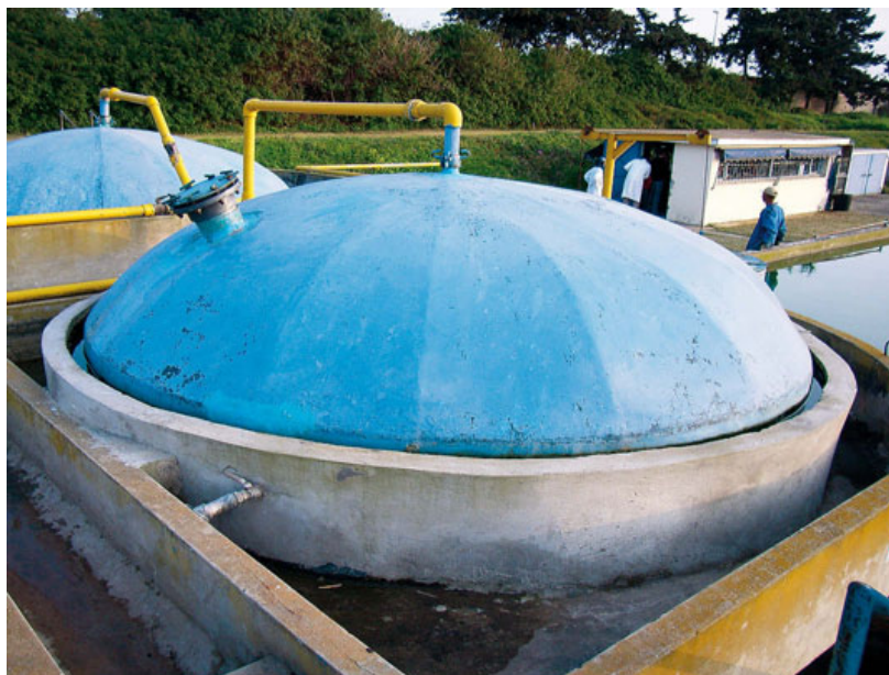
Figure 1: PRÉTRAITEMENT PAR DIGESTION ANÉROBIE, RAFADÉ
