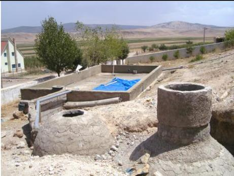
Poursuite de la construction du digesteur 4 m<sup>3</sup> et filtre planté pour l'école et la mosquée
