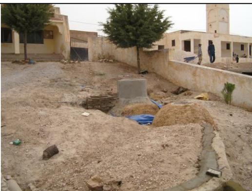
Isolation et remblaiement du digesteur de 4 m<sup>3</sup>
