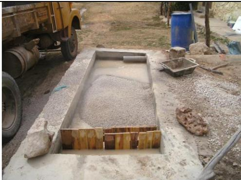
Remplissage d'un filtre planté d'une TDSU
