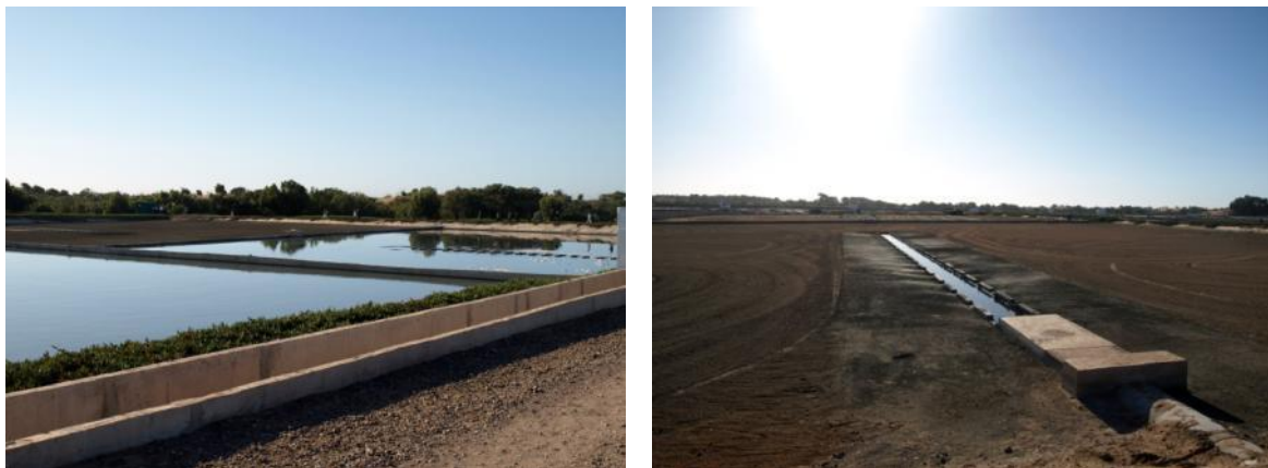
Figure 10 : Lit d'infiltration-percolation de la STEP M'Zar à Agadir
