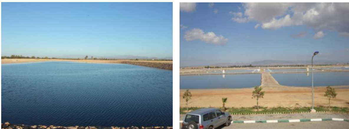
Figure 9 : Lagunage naturel à Tiznit et lagunage aéré à Oujda
