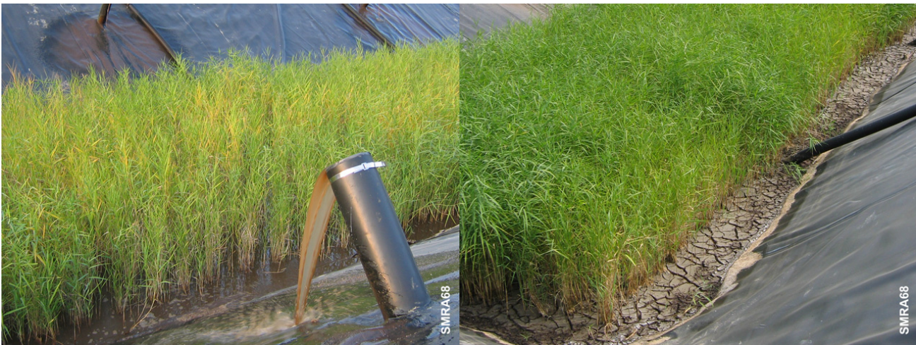
Figure 5-3: Exemple de lit de séchage planté de roseaux (en cours d'alimentation / en cours de séchage)
