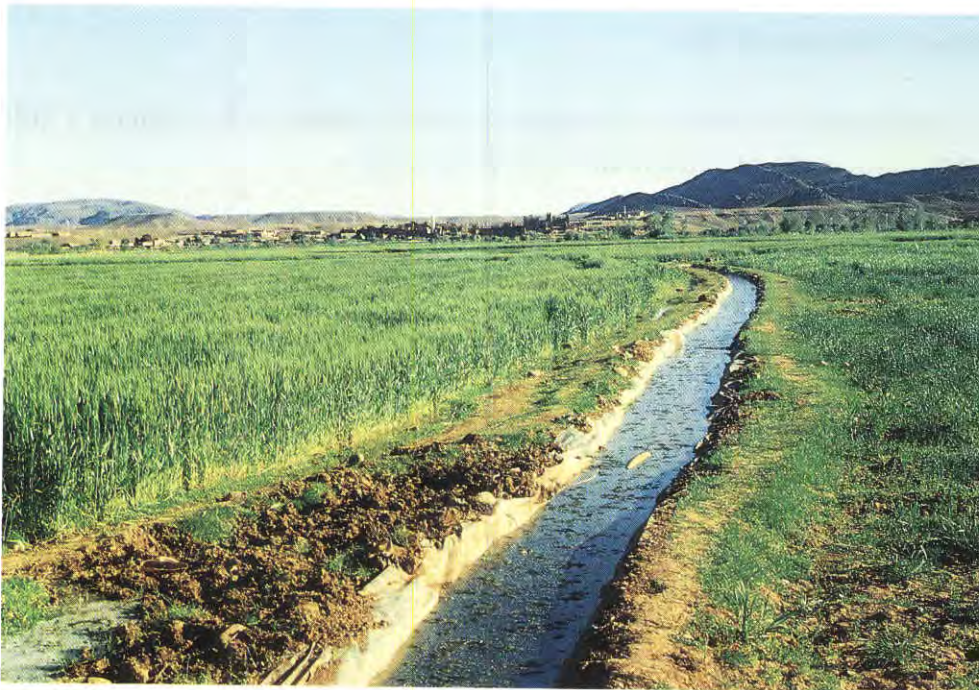
Séguia de distribution de l'eau épurée après reprofilage et imperméabilisation
