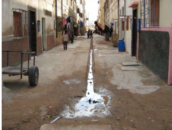
Figure 10 : Photo du chemin des eaux pluviales à Douar Rmel
