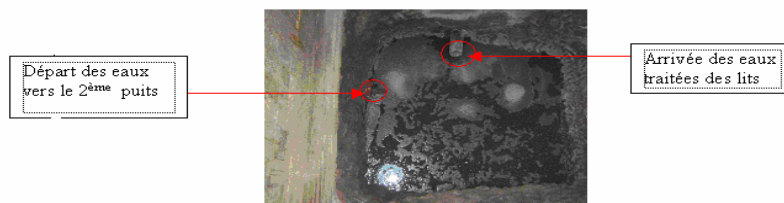
Figure 22 : Puits perdu N°1
