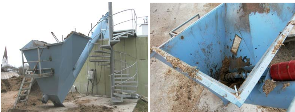
Abb. 35: Einfülltrichter mit Schnecke (rechts: mit Zerkleinerungseinheit im Trichter)
