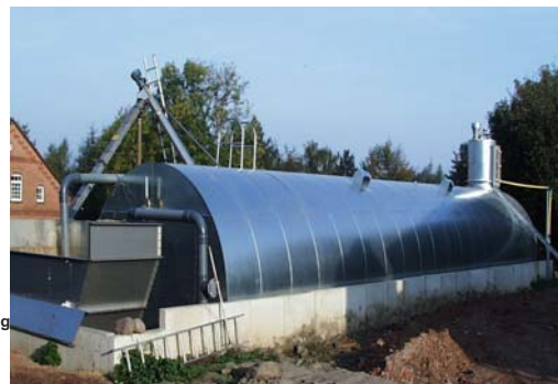
Abb. 28: Beispiel eines liegenden Fermenters, links mit externer Entschwefelung und Einrichtung zur Gasspeicherung
