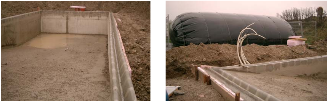
Abb. 30: Entleerter (links) und aktiver Fermenter (rechts) einer Anlage zur Feststoffvergärung im Grubenverfahren
