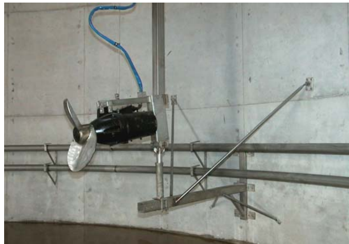
Abb. 46: Schwenk- und höhenverstellbares Tauchmotorrührwerk
