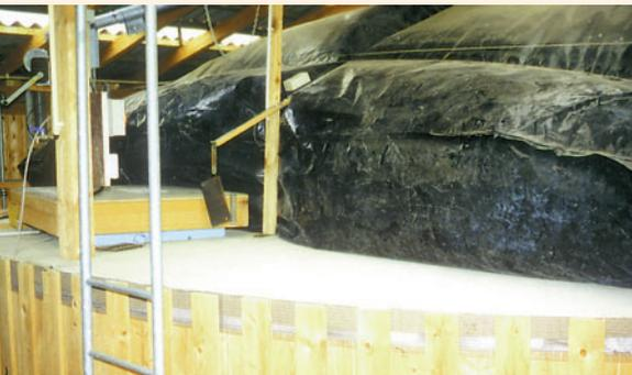
Abb. 7: Biogasfolienspeicher im belüfteten Dachraum über dem Faulbehälter
