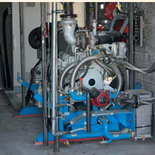
Abb. 8: BHKW-Aggregat einer Biogasanlage
