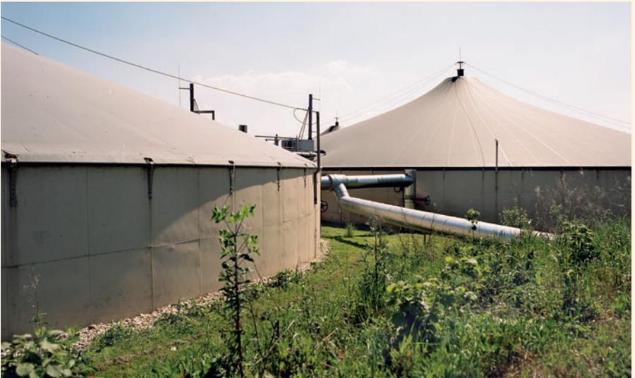
Abb. 6: Durchflussbiogasanlage mit Folienhaube als integrierter Gasspeicher
