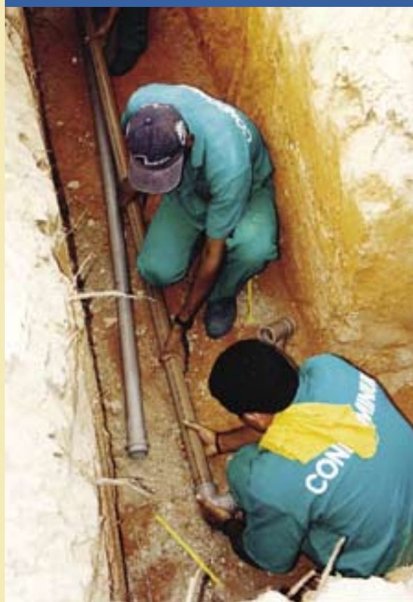
Instalación de la red pública de agua, Parauapebas
