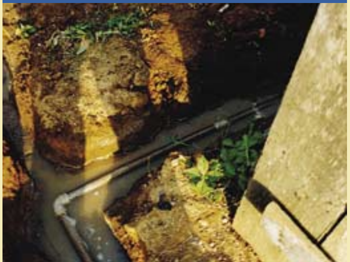
Ramificación condominial reparada, Parauapebas
