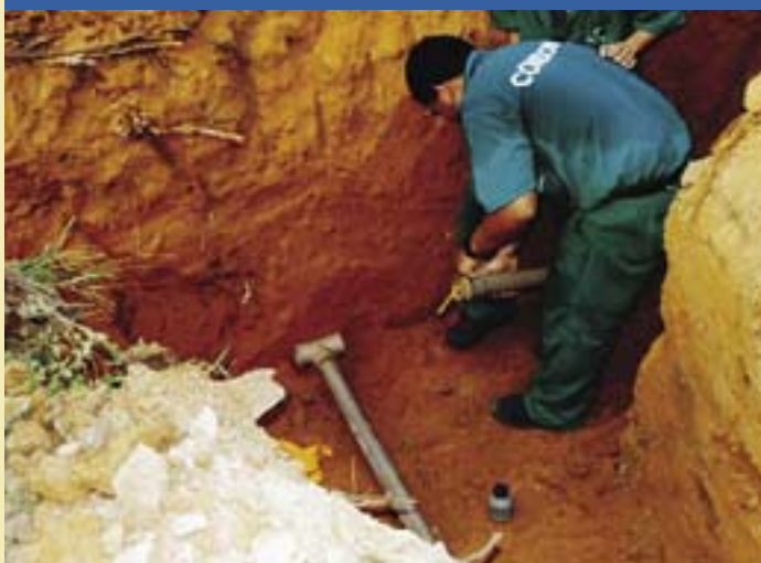
Instalación de la red pública de agua, Parauapebas
