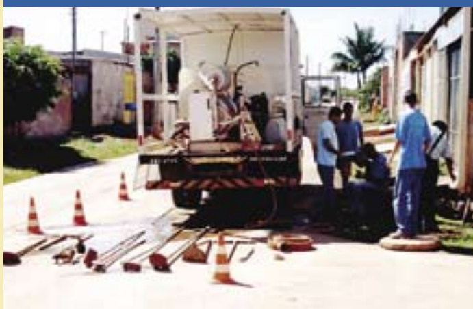
Equipo de mantenimiento para ramales condominiales, Brasilia
