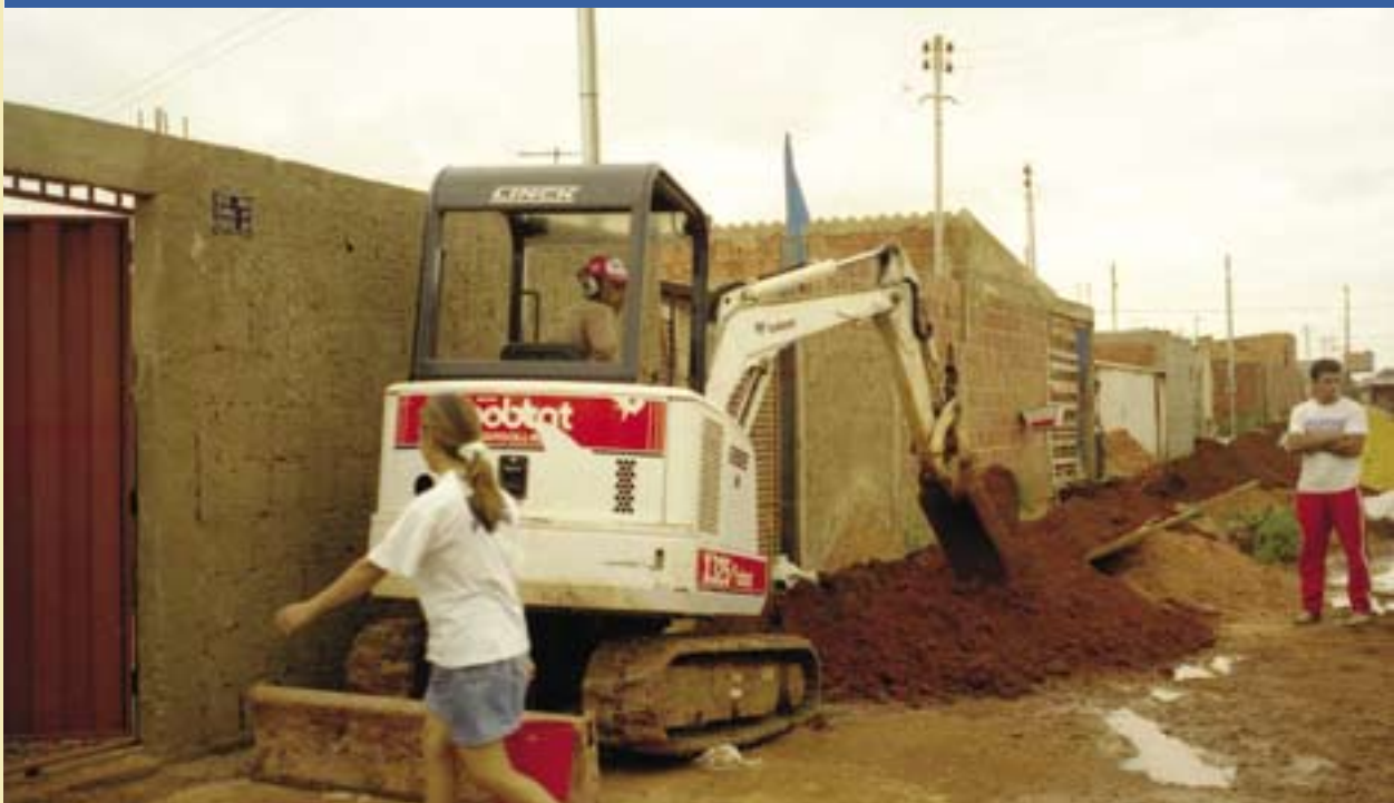
Excavación de red pública, Brasilia
