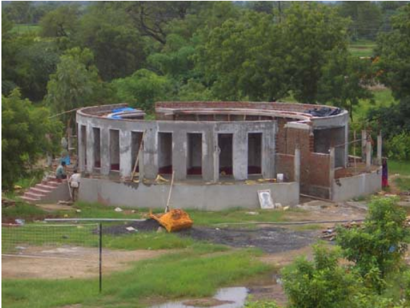
Abbildung 12 Ansicht des Sanitärkomplexes im Bau
