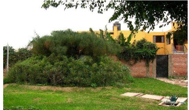
Fig. 19: Humedal para el tratamiento de aguas negras plantado con dos especies de papiro, después un año de funcionamiento.
