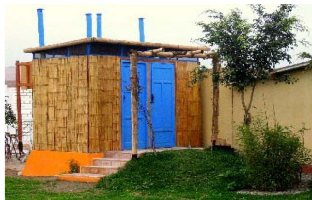
**Fig. 9:** SSOD, separación y recolección de orina, deshidratación de heces y tratamiento de aguas grises (a la derecha).
