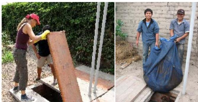
**Fig. 6:** Filtro de compostaje de doble compartimento para el pre-tratamiento de aguas negras (izquierda). Remoción del filtro (derecha)
