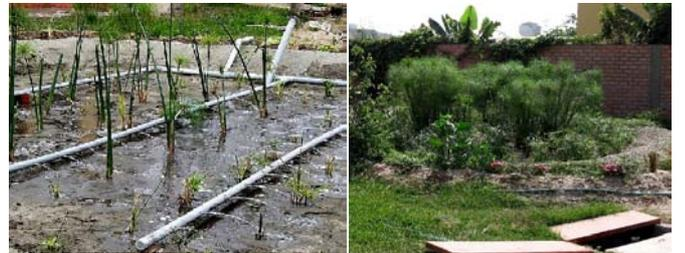
**Fig. 5:** Humedal de flujo vertical para el tratamiento de aguas grises durante el bombeo (un día después de la plantación y antes de la protección de las tuberías de distribución con 10 cm de grava, izquierda) y después dos meses, con un tanque de almacenamiento para la irrigación con aguas grises tratadas.
