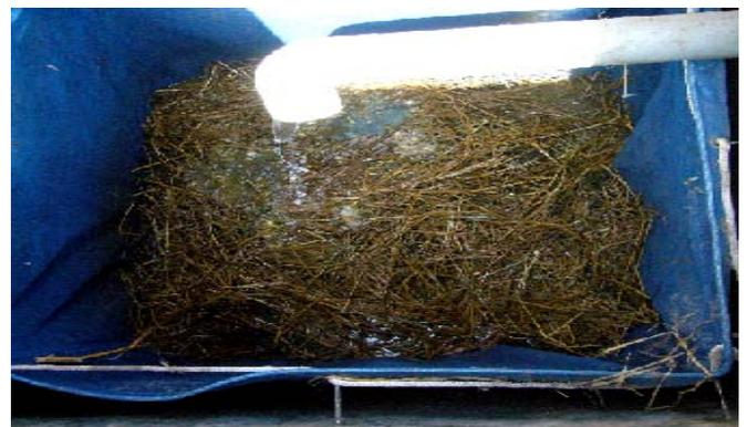
**Fig. 17:** Flujo de aguas negras creciente en la caja de compostaje (bolsa de filtro) debido a la fuga de agua en los baños de descarga hidráulico
