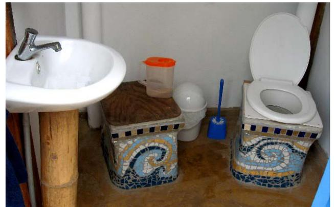
Fig. 10: El interior del baño (dos tazas de inodoros coloridos, solo una está en uso durante un año)
