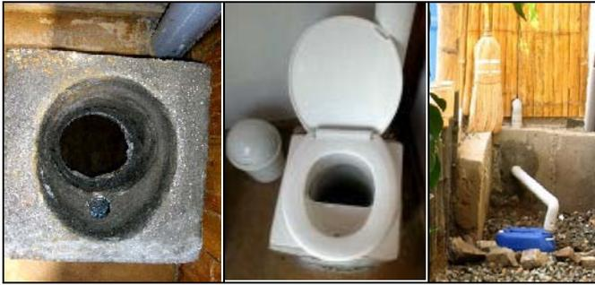
**Fig. 12:** Tazas de inodoros sin (izquierda) y con aditamento de plástico para la separación de orina (en medio). Tubería de la letrina hasta el bidón de 25 L (derecha)
