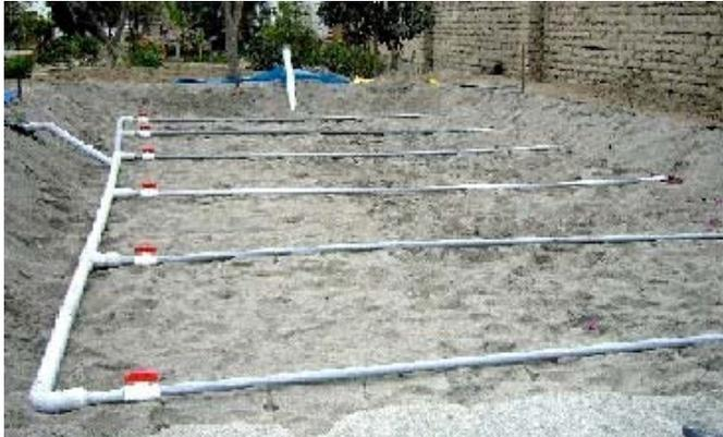
Fig. 18: La sistema de distribución en el humedal de tratamiento de aguas negras, válvulas para controlar la colmatación
