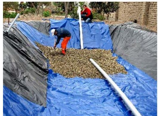
Fig. 3: Tubo de drenaje en la base del humedal para el tratamiento de aguas negras, cubierto con grava. Para impedir perforación por medio de la grava, el revestimiento de PVC de 0.5 mm (en negro) necesita protección, la cual es un segundo revestimiento (en azul) por dentro.
