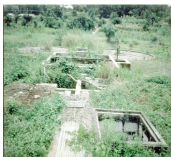
► Figura 1: sistema de tratamiento de aguas abandonado Kumasi, Ghana, 1970s
