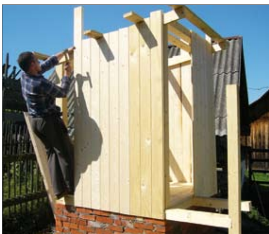
fig. 6: Construirea în afara locației a cadrului din lemn pentru pereții cabinei de toaletă (sus), montarea pereților din scânduri de 2 cm grosime (jos)
