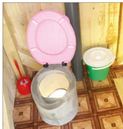
Fig. 1: Toaletă uscată S.S.U. cu două compartimente: vedere din exterior (stânga) și vedere din interior (dreapta)
