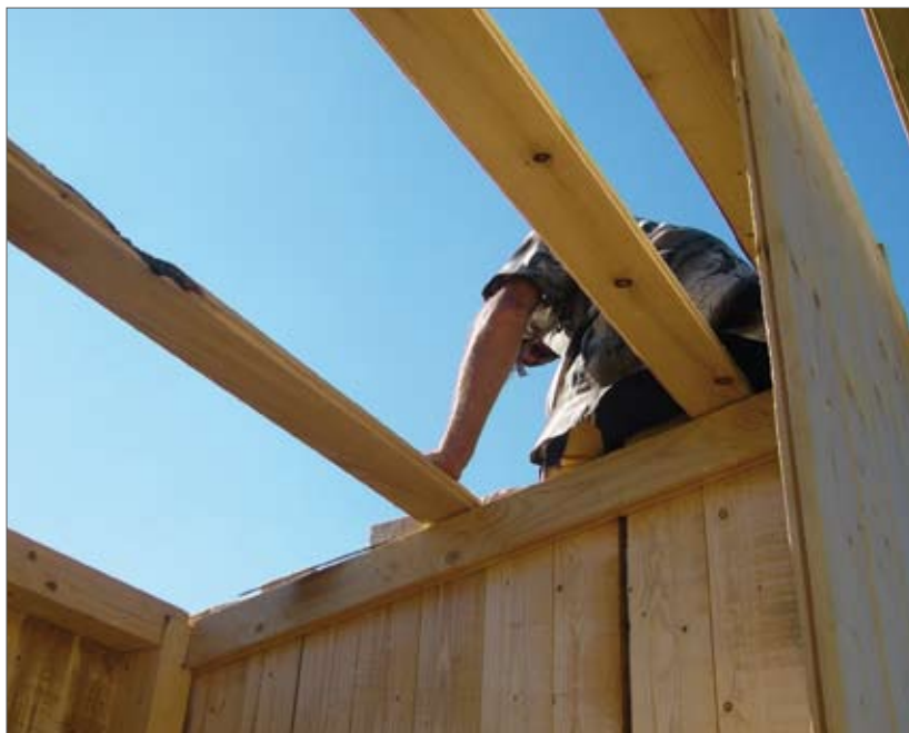
fig. 7: Montarea grinzilor din lemn pentru acoperiș (stânga) și a acoperișului din tablă zincată (dreapta)
