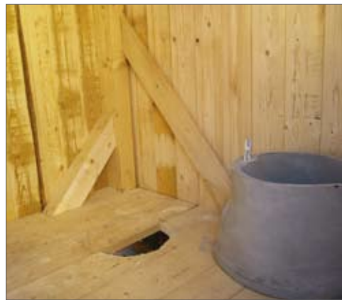
fig. 5: Cadrul pentru podeaua cabinei de toaletă (stânga) și decuparea găurii pentru scaunul cu capac (dreapta)
