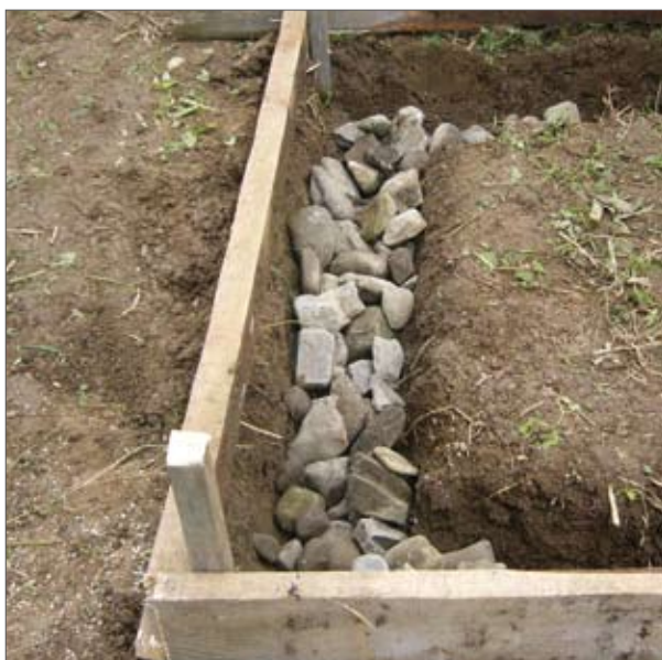
fig. 2: Excavare pentru centură (sus) și umplere cu pietre (jos)
