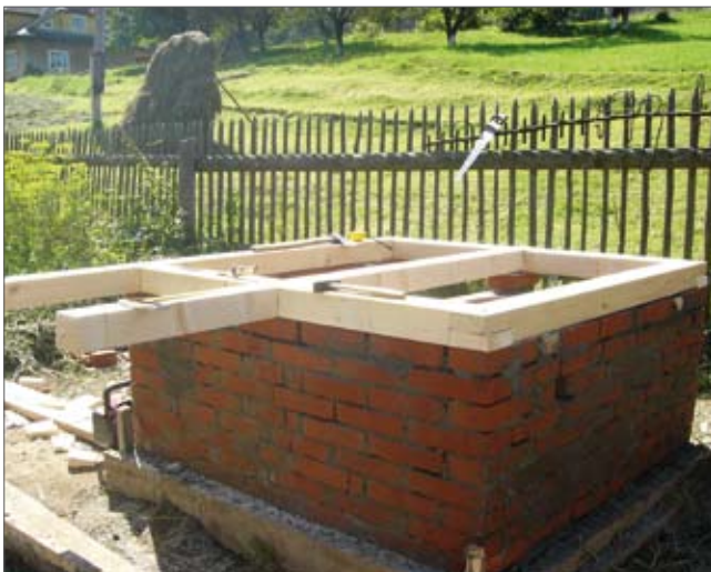
fig. 5: Cadrul pentru podeaua cabinei de toaletă (stânga) și decuparea găurii pentru scaunul cu capac (dreapta)
