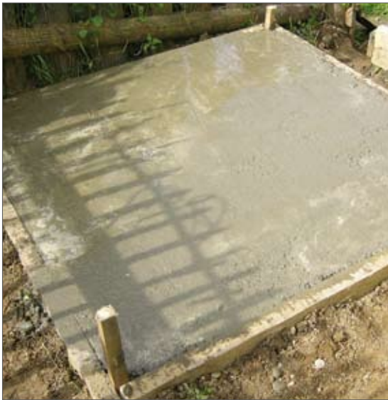
fig. 3: Podea din beton a compartimentelor pentru fecale: cofraj (sus), finalizată (jos)
