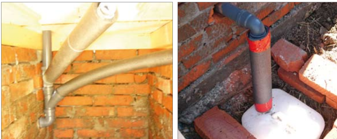
fig. 10: Furtun de urină de 25 mm cu izolație și conducte PP de 50 mm în interiorul compartimentelor pentru fecale (stânga); mic recipient de urină de 20 litri în afara toaletei (dreapta)
