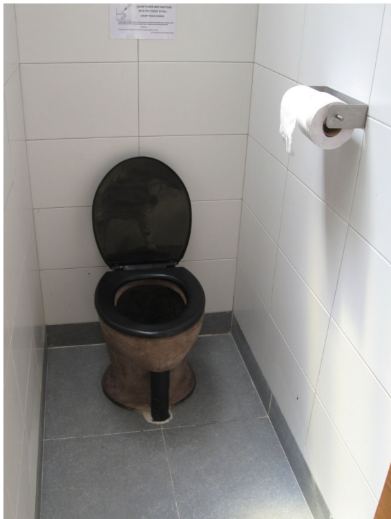
Abb. 15 Handgefertigte Betontoilette mit Terrazzo-Oberfläche (Design: Berger Biotechnik). Das Tageslicht kommt durch ein Oberlicht.
