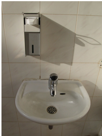
Abb. 09 Handwaschbecken mit hochdichter Oberfläche, um Reinigungsaufwand und Wasserverbrauch zu reduzieren (Keramag).
