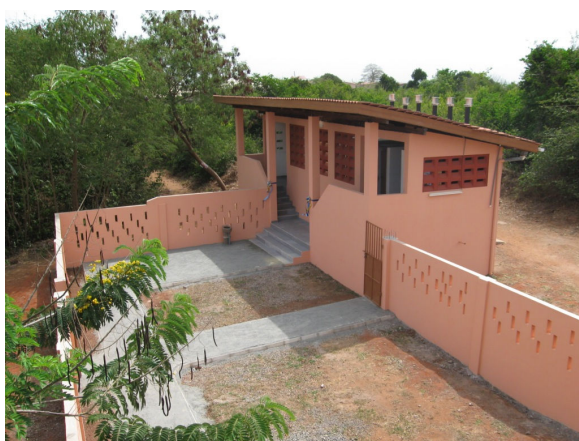
Abb. 11 Eingangsbereich des Trockentoilettengebäudes. Der ummauerte Hof ist nur vom Wohnheim aus zugänglich.
