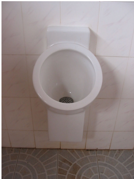
Abb. 07 Trockenurinal mit pflegeleichter Oberfläche, um die Ablagerung von Urinkristallen zu reduzieren (Keramag).
