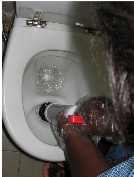
Abb. 04 Regelmäßige Wartung zur Sauberhaltung des Urinablaufs mit einer Abflussreinigerpumpe (ca. 1 x /Woche)
