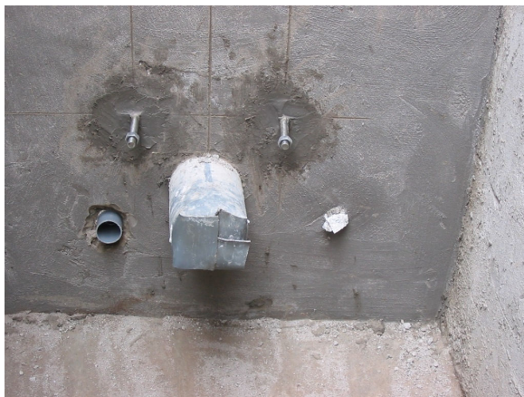
Abb. 01 Vorgemauerte Installationswand zur Aufnahme der Ver- und Entsorgungsanschlüsse und Halterungen (Trenntoilette).
