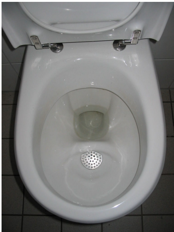
Abb. 03 Trenntoilette mit 4- und 2 l-Spülung. Das Sieb schützt den Urinablauf vor Verstopfungen mit Toilettenpapier (BB)
