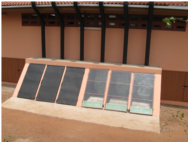
Abb. 13 Abgetrennte Sammelkammern für Fäzes mit je 2 Wechselbehältern. Die Urinsammeltanks befinden sich rechts und links hinter den Holztüren.
