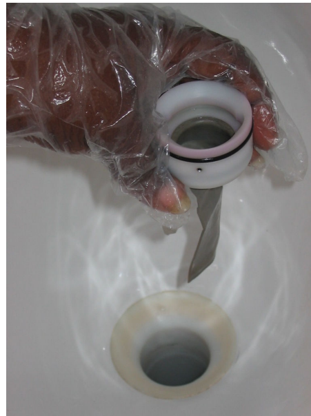
Abb. 08 Membranventil als Geruchsverschluss. Die schlauchartige Membrane schließt sich, sowie der Urinfluss nachlässt (Keramag).
