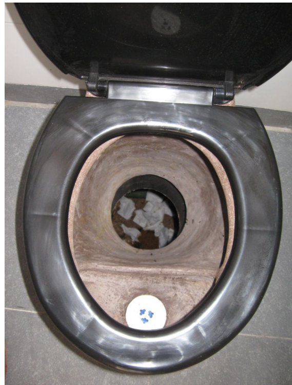
Abb. 16 Urintrennung mit Membranventil. Alle Oberflächen sind mit Flüssigwachs behandelt.
