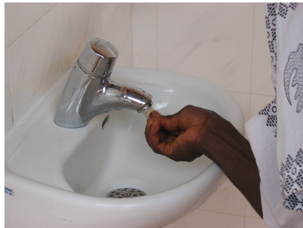
Abb. 10 Pneumatische Selbstschlussarmatur mit einstellbarer Durchflusszeit. 2 x 4 Sek. reichen fürs Einseifen und Abspülen (Geberit).
