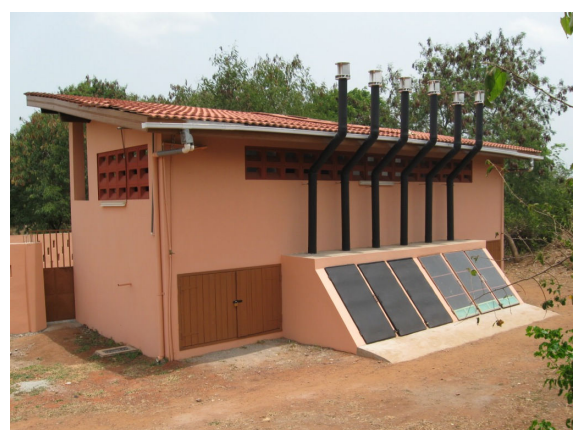
Abb. 12 Die Rückseite des Toilettengebäudes zeigt nach Süden, um die Sonnenerwärmung zur Trocknung der Fäzes zu nutzen.
