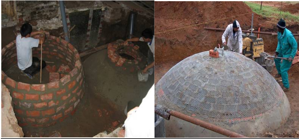
Figure 9 : Gauche : Construction d'un méthaniseur au vietnam (Photo : F. Klingel, 2005), Droite : cuve de production de biogaz (Photo : M. Lebofa, 2006)
