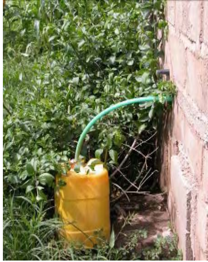
Figure 7 : Collecte des urines d'une toilette dans un bidon de 20 litres
