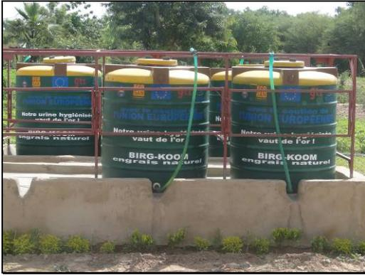
Photo 3. Polytanks de stockage d'urines sur des supports
