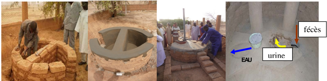
Figure 5 : Construction d'une latrine sèche
