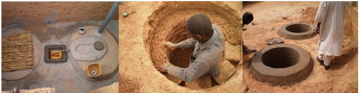
Photos 1 : Confection d'une latrine à compost type APA
