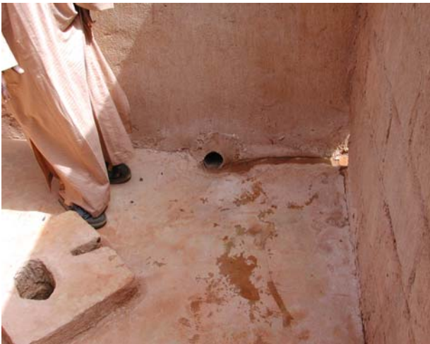
Fig. 2: Vue interne d'une latrine traditionnelle
