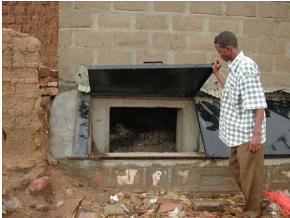
Fig. 6: Vue de derrière de la toilette avec les ouvertures pour recueillir les boues fécales sèches.
