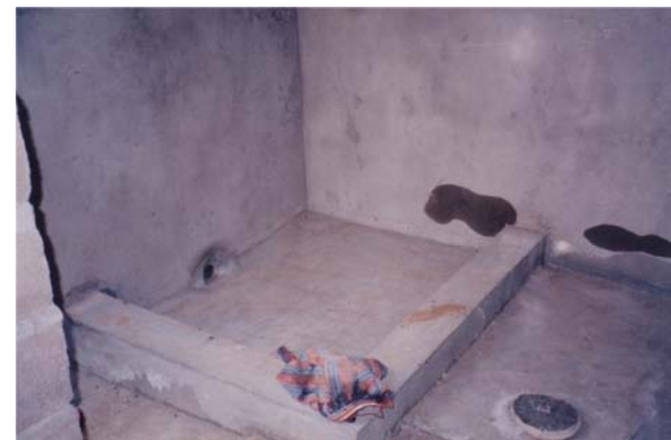
Fig. 5: Réalisation la douche sur le plancher de la toilette (avec écoulement dévié de l'eau grise)
