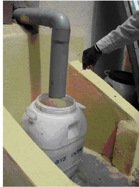
Fig. 8: Collecte de l'urine obtenue séparément
