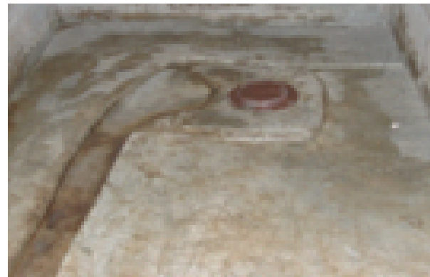
Fig. 4: Réalisation d'un plancher de toilette (avec douche séparée)
