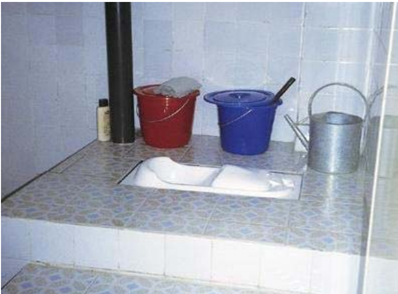
WC à la turque à séparation d'urine en Chine Conception Lin Jiang (Source : U. Winblad, Suède)
