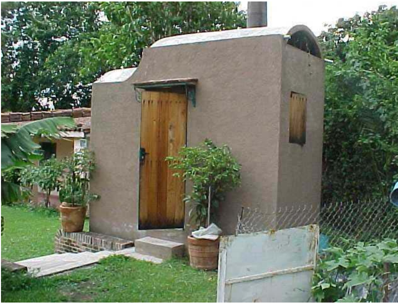
Toilettes sèches à séparation d'urine au Mexique (Source : S. Esrey, Unicef, New York)
