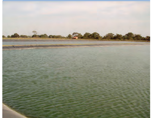
Figura 13: Lagunas de estabilización en Montero con lagunas anaeróbicas
