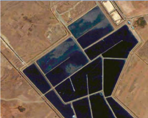
Figura 12: La planta en Puchukollo con lagunas anaeróbicas
