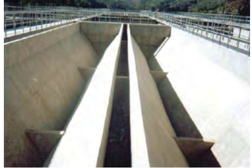
Figura 30: Tanque Imhoff en Sucre
