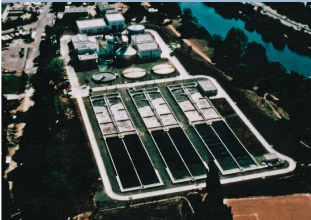
Figura 37: Planta de lodos activados (Saarbruecken/Alemania)
