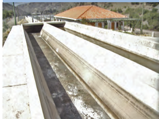
Figura 3: Desarenador en Sucre
