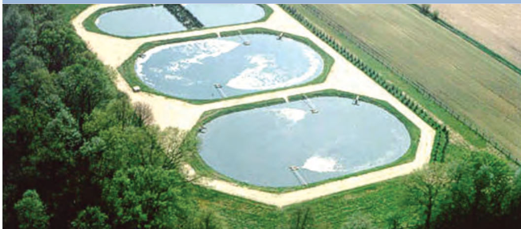
Figura 38: Lagunas con aireación (Alemania)
