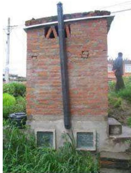
Abbildung 3: Zweikammer UDD Toilette, Innen- und Außenansicht (Quelle: [www.gtz.de](http://www.gtz.de))
