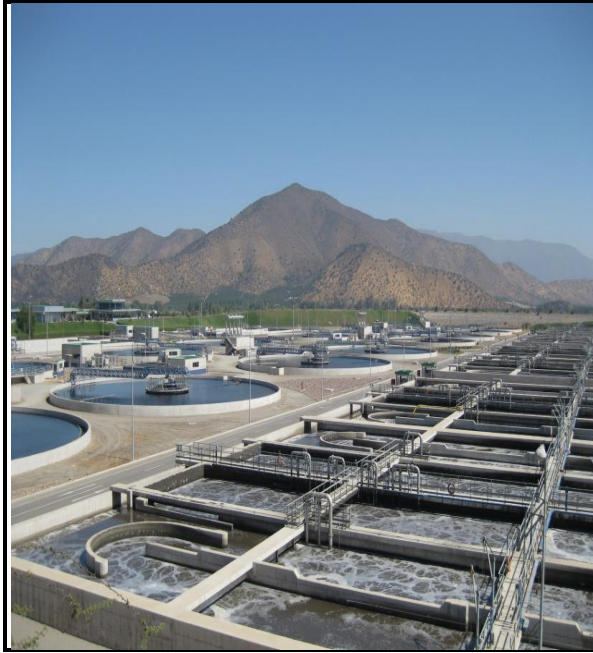
Foto 2: Kläranlage La Farfana
