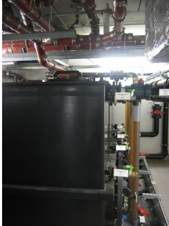
PE urine storage tanks (4 x 2500 L)
