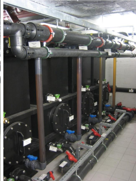
PE urine storage tanks (4 x 2500 L)
