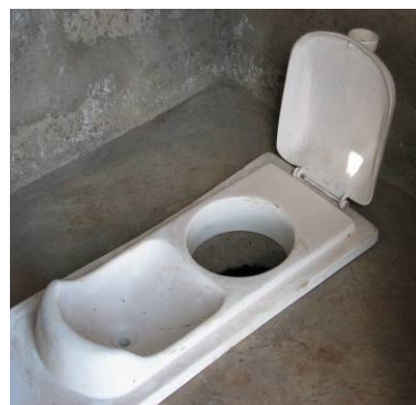
Abbildung 7: Urinseparierende Hocktoilette
