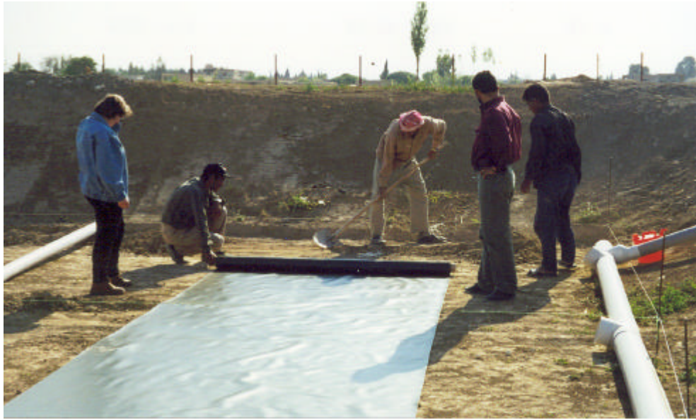
Auslegung der Abdichtungsfolie (eigenes Foto)
