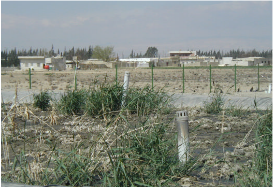
Abb. 15: Schlammbehandlungsbeet nach 5 Monaten (eigenes Foto)
