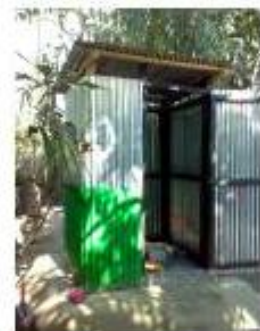
Urine diversion latrine
