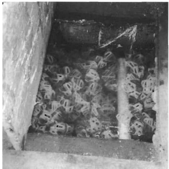
**Fig. 21:** Billes flottantes en plastique comme matériau filtrant. Lorsque le film bactérien devient trop lourd, les billes se retournent et versent leur chargement. Ce matériau filtrant a été utilisé avec succès pour des eaux usées provenant de la fabrication du "tofu" par HRIEE dans la province de Zhejiang en Chine, [photo: Sasse]
