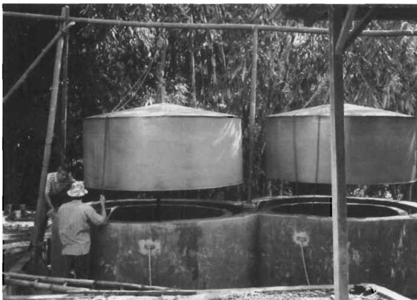
**Fig. 57:** Système à caisson flottant. Les caissons ont ici été enlevés pour être repeints, ce qui donne une vue du mur double assurant l'étanchéité par l'eau. Construit par LPTP et BORDA pour un abattoir à Java (Indonésie) [photo: Sasse]
