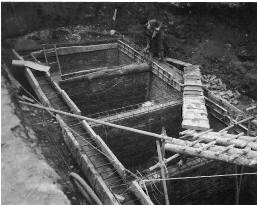
*Fig. 3: Filtre anaérobie de type DEWATS en construction. Conception et encadrement assurés par CEEIC [photo: Sasse]*
