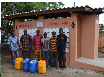
Collecte des déchets publics, site de compostage et latrines EcoSan publiques
