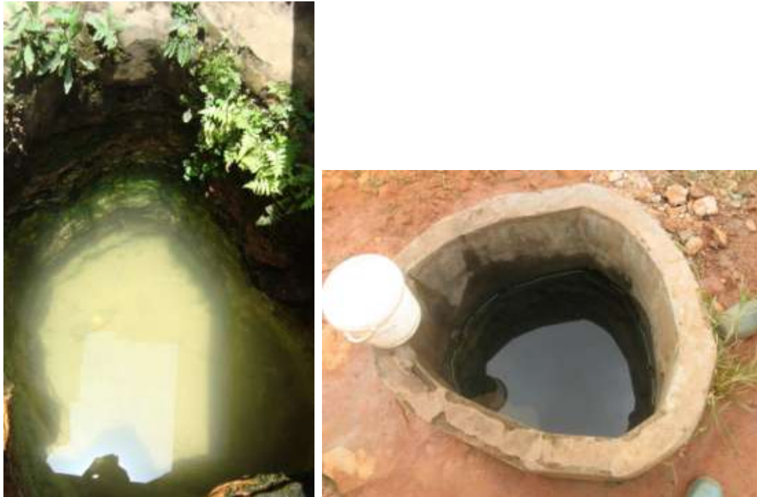
Figure 11: A gauche, un puits dans un état d'entretien favorisant un biotope, comparé (à droite) à un puits mieux entretenu normalement protégé de la lumière - (left) Dug well (puits) in the maintenance state of a biotope compared (right) to a better kept dug well normally protected from light.
