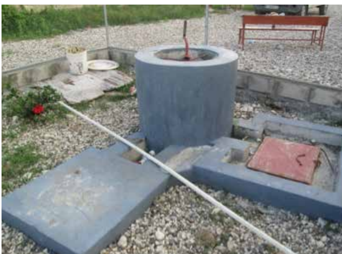
Photo NCA_5: biodigester ASPAM; entrée déchets animaux.
