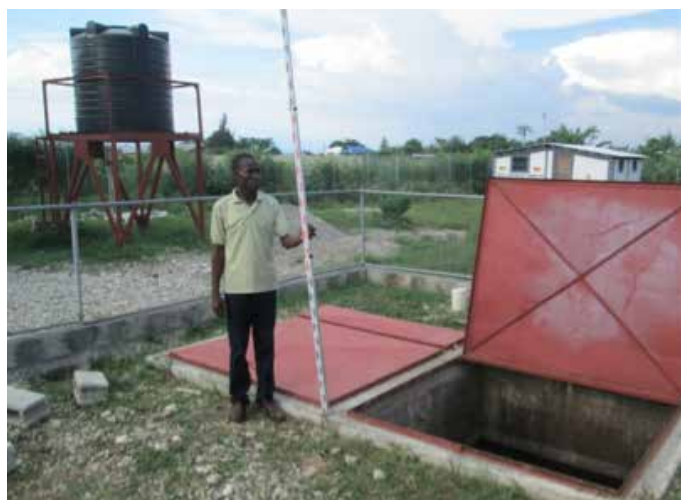
Photo NCA_6: biodigester ASPAM; réservoir of fertilised water.
